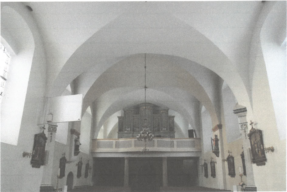
Fot. nr 30, 31 Kościół św. Wawrzyńca w Luzinie. Nawa kościoła. Ode strony chóru i ołtarzy bocznych. Stan obiektu przed pracami , fot. Elżbieta Przebirowska, luty 2024r..
